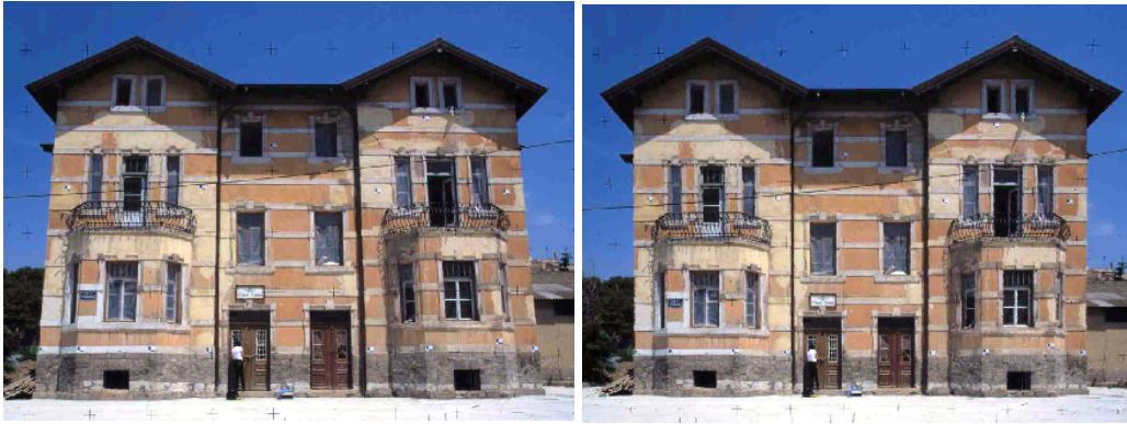
Εικόνα 53. Ορθοαναγωγή εικόνας από φωτογραφία με χρήση φωτογραμμετρίας
