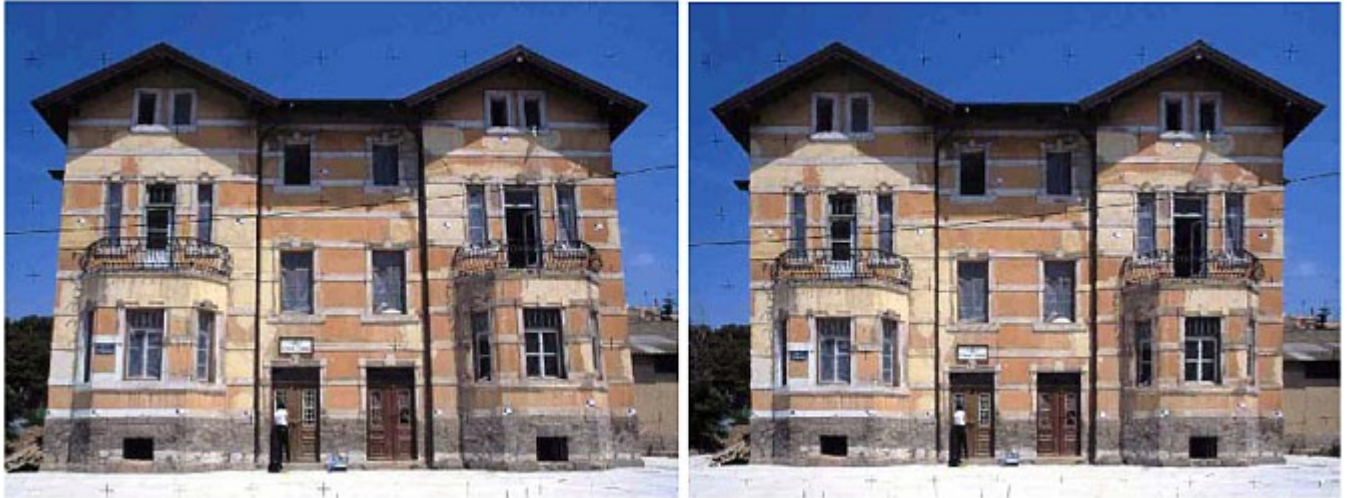
Εικόνα 10 (α). Αρχική εικόνα. Είναι εμφανής η παραμόρφωση που υφίσταται το κτίριο λόγω της κεντρικής προβολής. (β). Τα σφάλματα λόγω κεντρικής προβολής και κλίσης έχουν απαλειφθεί
